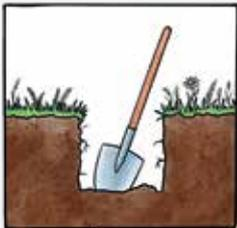
**1.** Loch oder Graben ausheben und anschließend Seitenflächen und Boden mit Wasser anfeuchten. Fundamente sollten frostfrei 80 cm tief gegründet werden.
