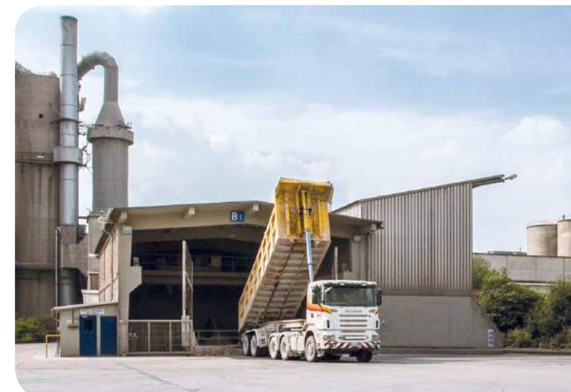
Brecheranlage im schallgeschützten Keller aufgestellt
