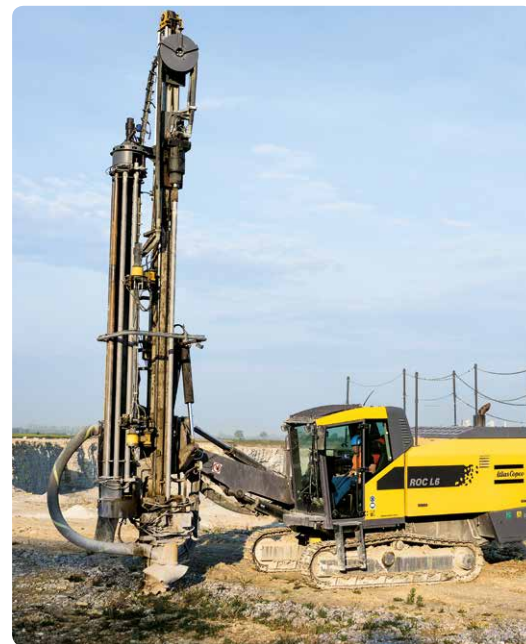
Die moderne Bohrmaschine zum Bohren der Sprenglöcher ist mit einer Entstaubungseinrichtung ausgerüstet.
