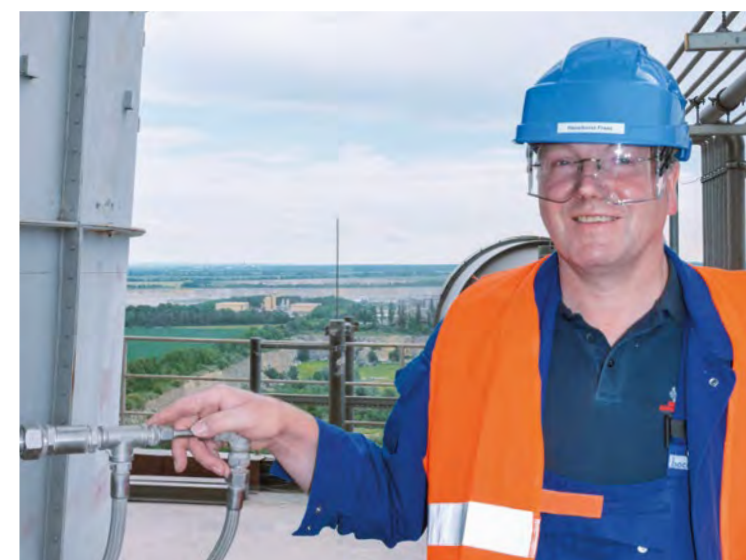
Herr Haselhorst bei einer Kontrolle an der Messstelle am Abluftkamin der Drehhofenanlage.
