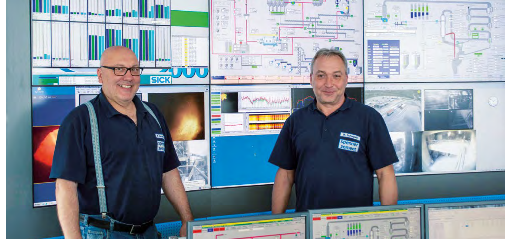
Im zentralen Spenner Leitstand – werkseigene Überwachung der Prozesse und Emissionen. V. l. n. r.: Herr Harrenkamp, Herr Schadwill
